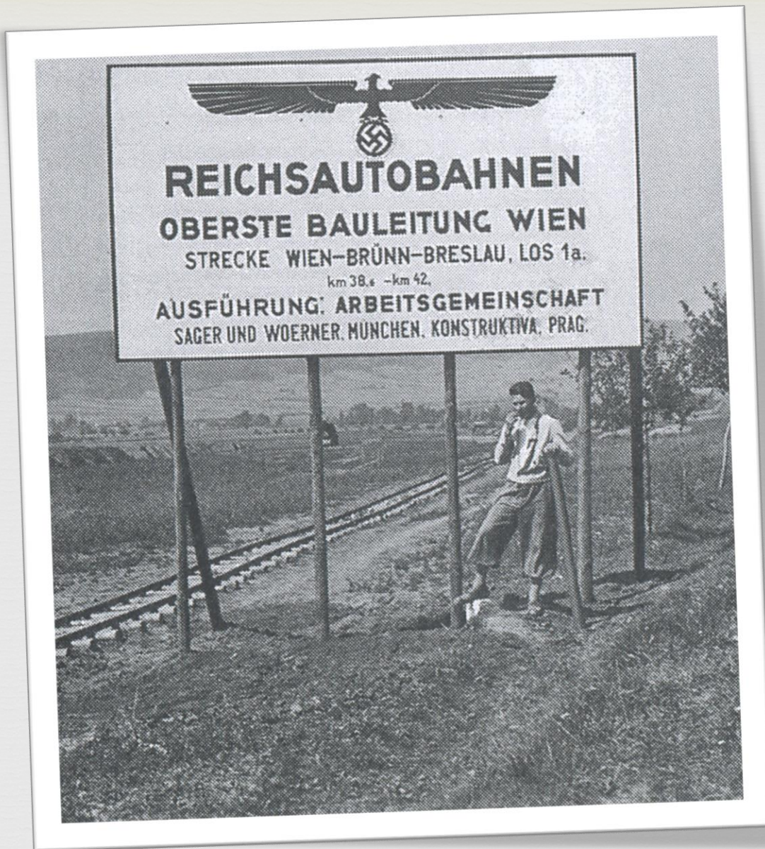
Informační tabule o stavbě dálnice
